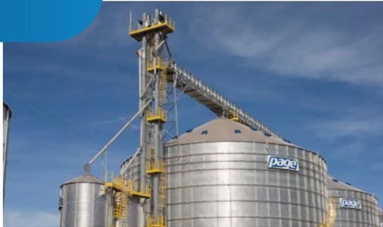
Los elevadores de cereales Pagé están diseñados para operar en el movimiento vertical de gránulos sólidos en régimen continuo. Construidos enteramente en chapas de acero galvanizado, tienen capacidad de 5 a 1.500 ton./hora y poseen accionamiento por motor reductor.
