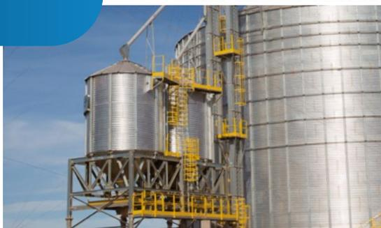
Los silos de fondo Cónico de Industrial Pagé pueden ser utilizados como almacenaje temporal en la recepción o secado, regulando el flujo del producto y optimizando el rendimiento de los equipos. También pueden utilizarse para la expedición a camiones y/o ferrocarriles.
